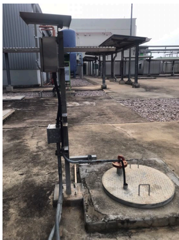
ภาพที่ 2.2-11 Oil Separator สำหรับแยกน้ำมันปนเปื้อนน้ำมัน
