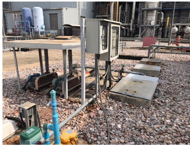
ภาพที่ 2.2-10 บ่อบำบัดสำเร็จรูป (Septic tank) ชนิดเติมอากาศ
