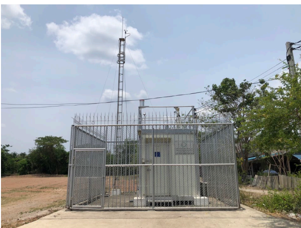
ภาพที่ 2.2-4 สถานีตรวจวัดคุณภาพอากาศในบรรยากาศ โดยทั่วไปแบบต่อเนื่อง (AQMS) บริเวณบ้านชาวเหนือปัจจุบัน
