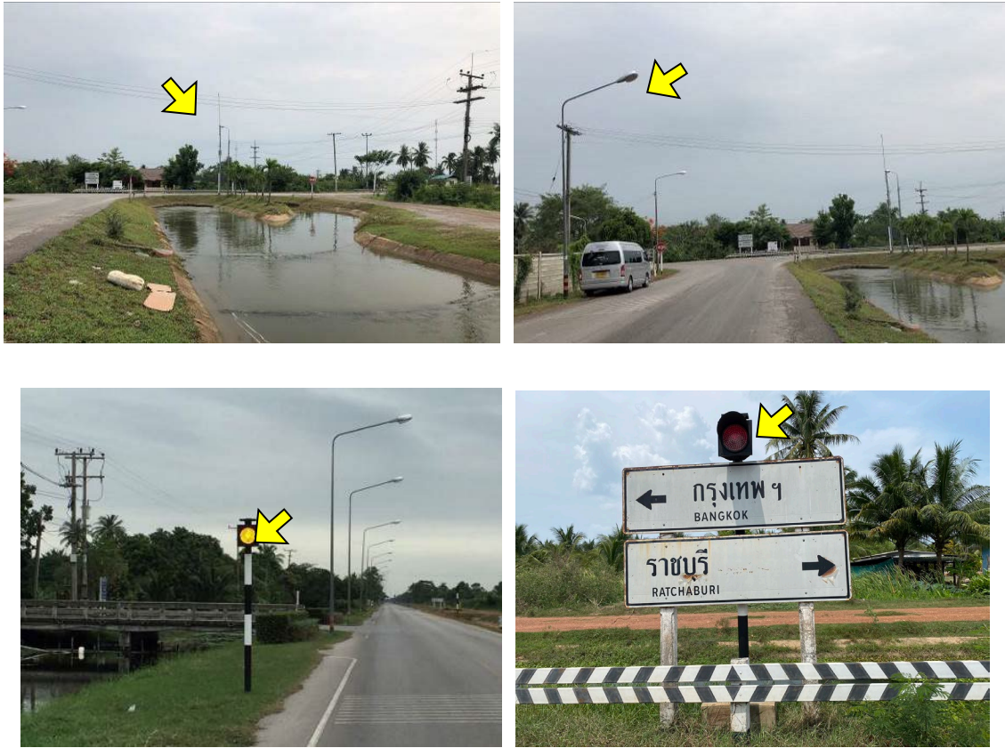
ภาพที่ 2.2-36 ติดตั้งไฟฟ้าแสงสว่างและไฟกระพริบเพิ่มเติม ในพื้นที่ชุมชนเพื่อลดอุบัติเหตุ
