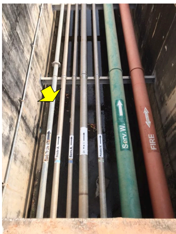
ภาพที่ 2.2-14 การนำน้ำจาก HRSG Blow down และหอหล่อเย็นที่บำบัดแล้วมายังบ่อน้ำพุ เพื่อการปรับปรุงทัศนียภาพและนำมารดน้ำต้นไม้ภายในบริเวณโรงไฟฟ้า เพื่อลดการทิ้งน้ำออกสู่ภายนอกให้น้อยที่สุด
